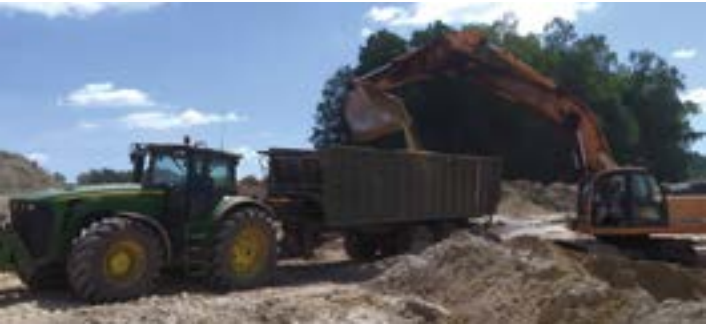
Lucrari de constructii
