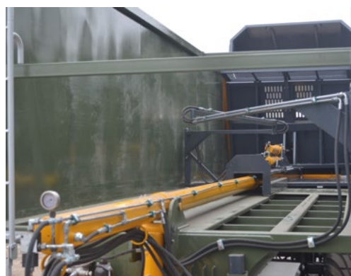
Hydraulický systém pohyblivé stěny
