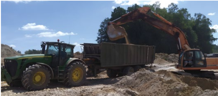
Lavori di costruzione
